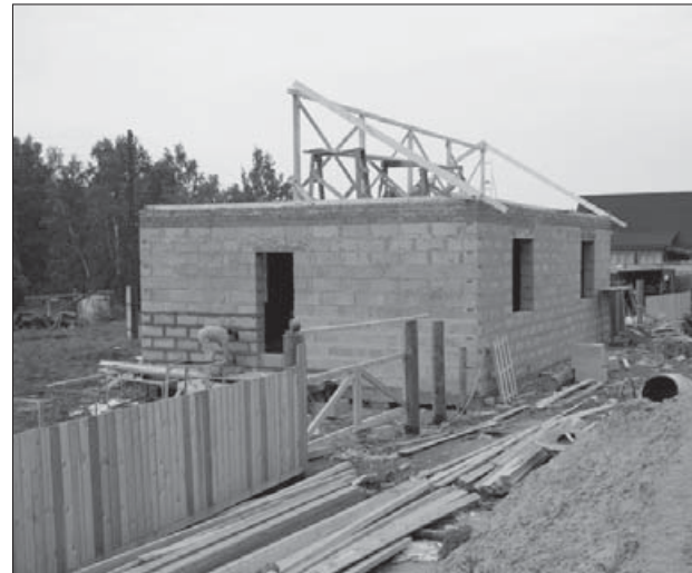
В Куйтунском районе ведется строительство домов для детей-сирот
