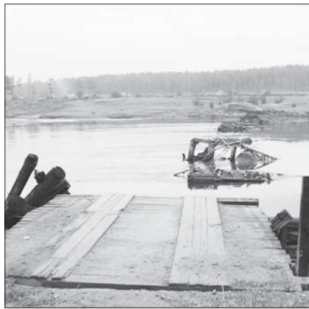
В пос. Октябрьск мост снесли паводковые воды
